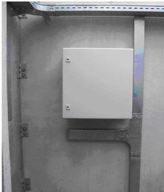
Figuur 6-1 Voorbeeld van montage wandkast aan muur in SCL compartiment (patio)
